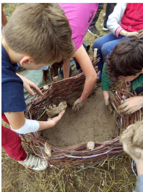
construction d'un four à galettes : clayonnage & torchis
